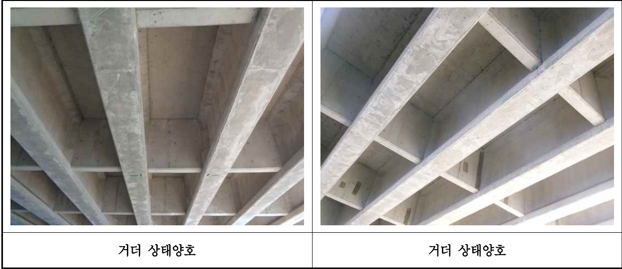
【사진 1.3.5】 거더 손상현황
