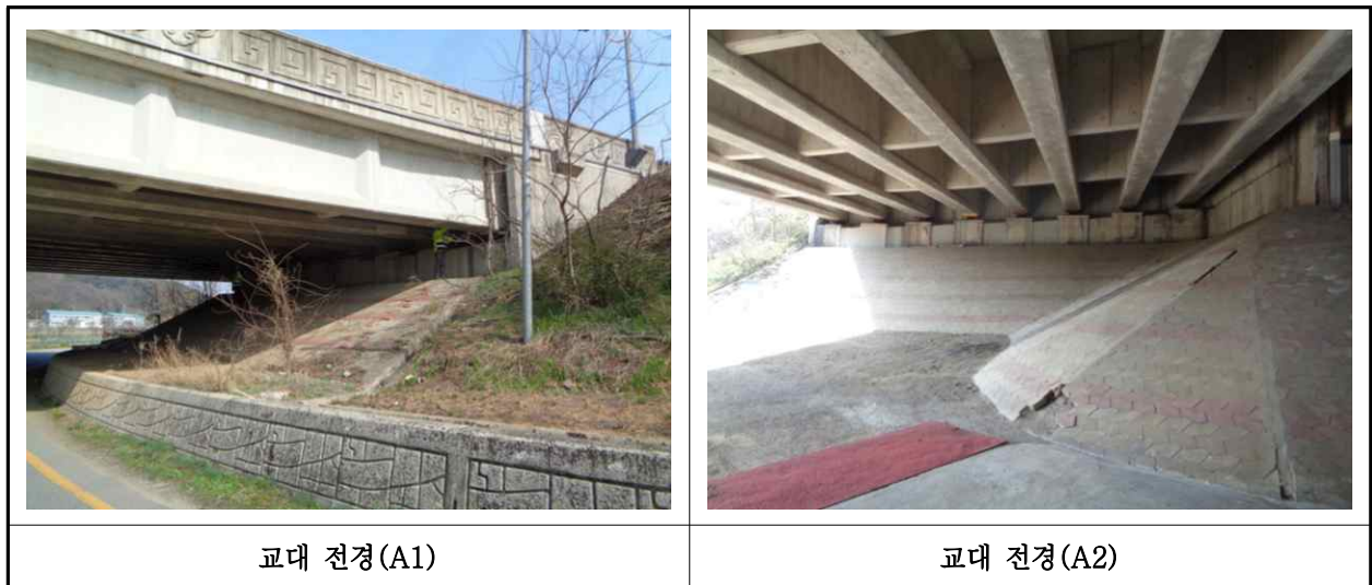
【사진 1.3.8】 교대 전경
