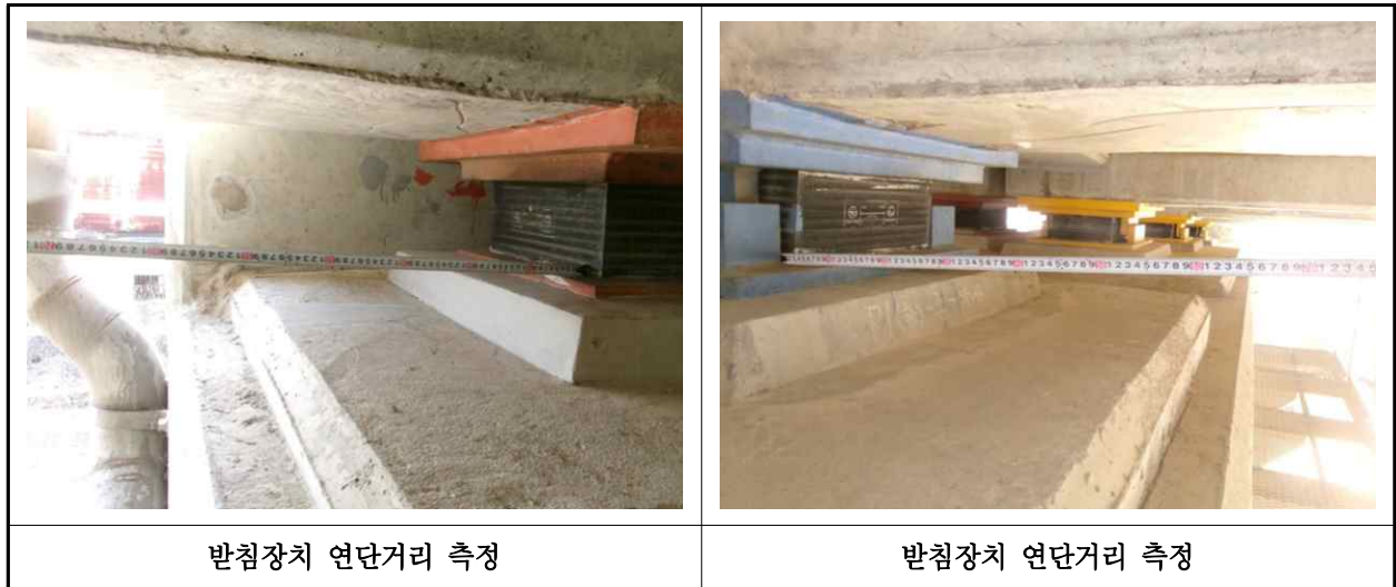
【사진 1.3.14】교량반침장치 연단거리측정
