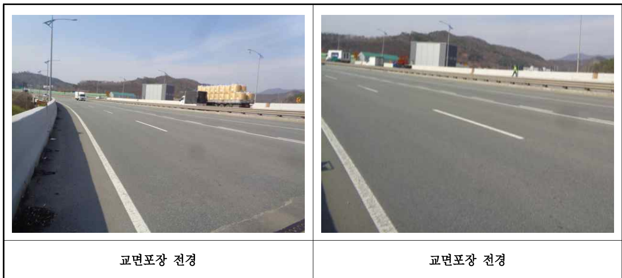
【사진 1.3.19】 교면포장 전경
