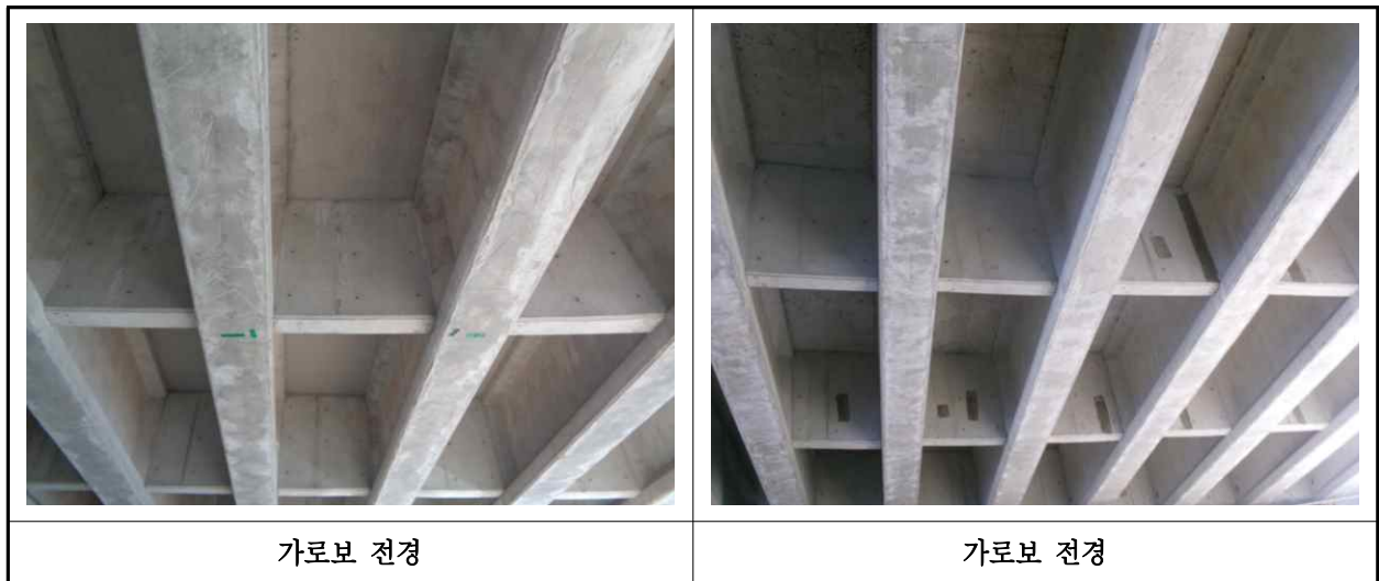
【사진 1.3.6】 가로보 전경
