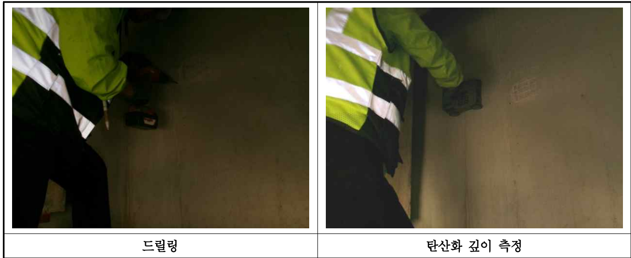
【사진 1.4.2】 탄산화 깊이 측정 현장사진
