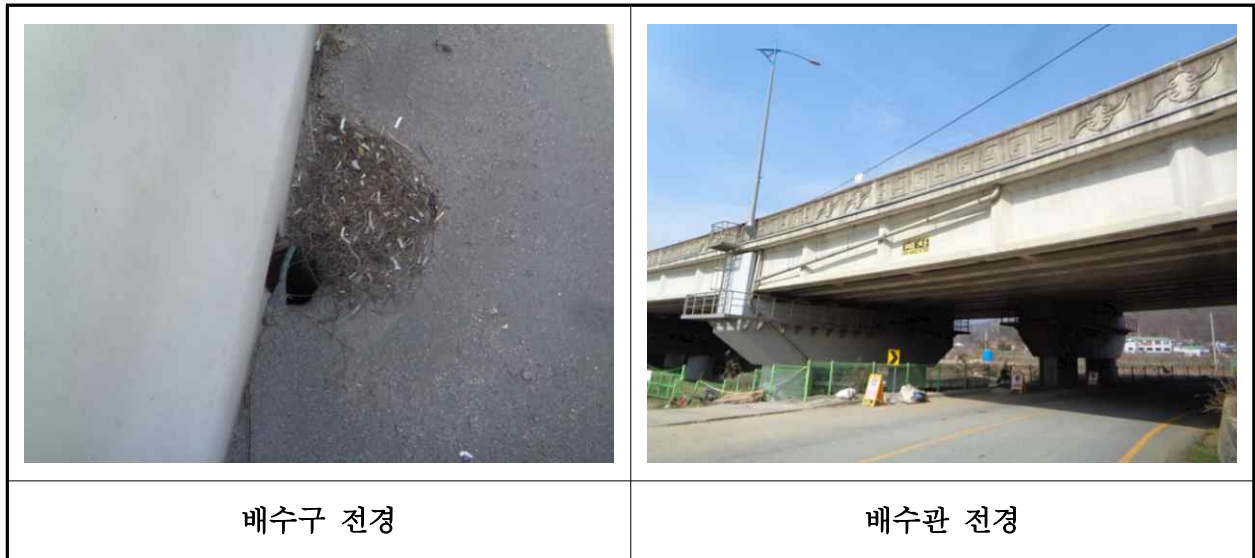
【사진 1.3.21】 배수시설 전경
