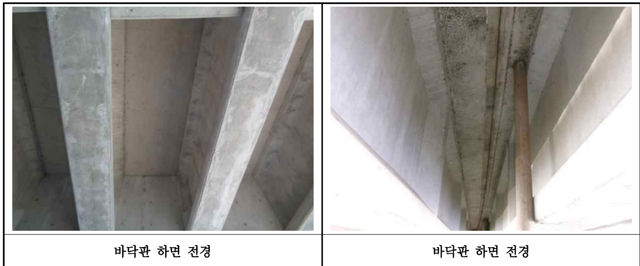
【사진 1.3.2】 바닥판하면 전경
