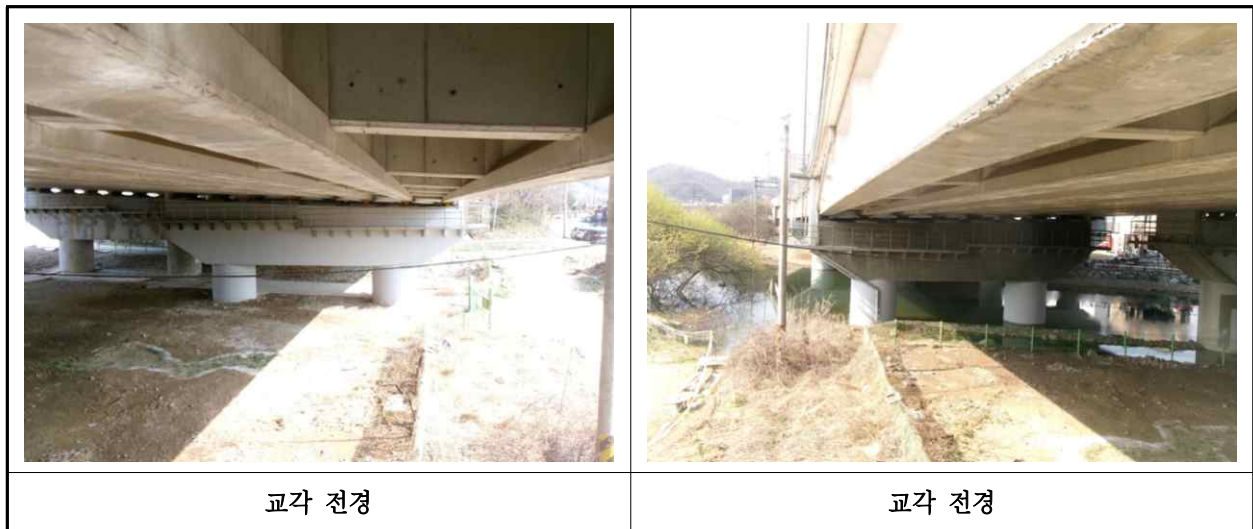
【사진 1.3.10】 교각 전경
