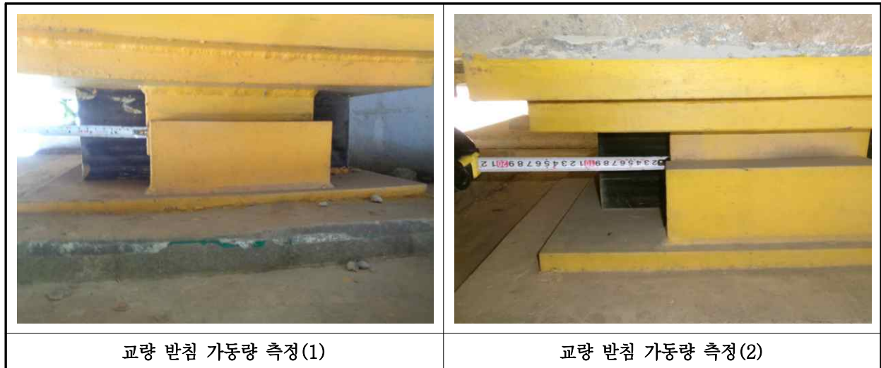
【사진 1.3.15】교량받침 이동량 측정
