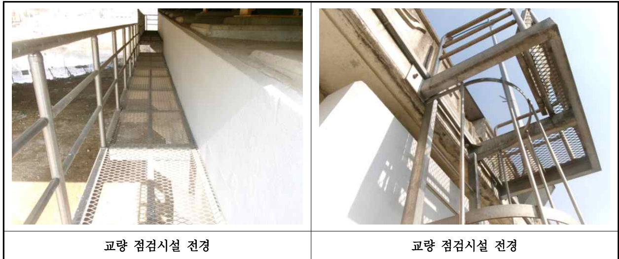
【사진 1.3.25】 교량 점검시설 전경
