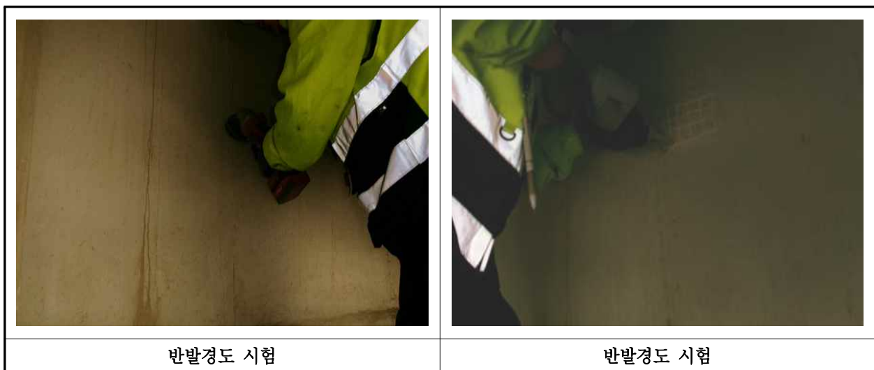
【사진 1.4.1】 반발경도시험 현장사진
