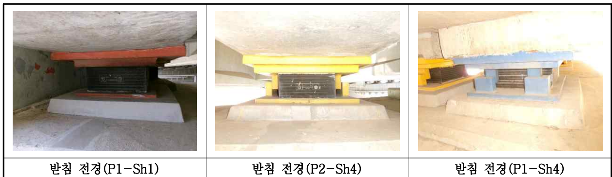
【사진 1.3.12】 교량받침 전경
